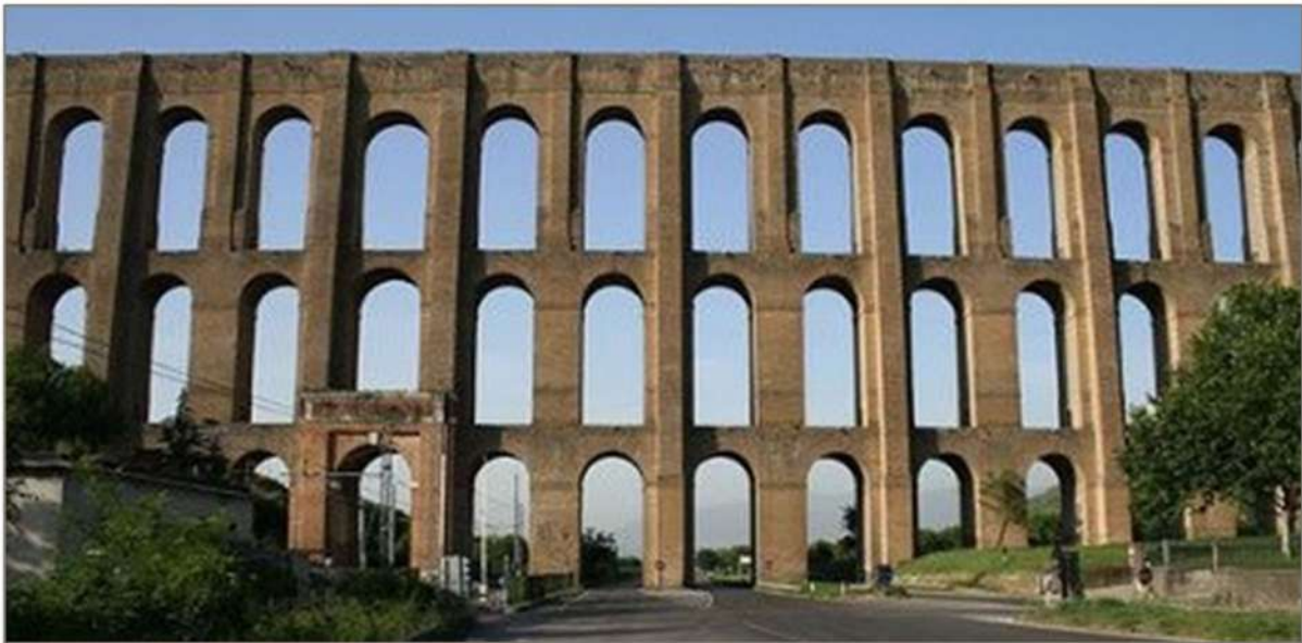
Figura 3.110 - Acquedotto Carolino. Foto da Piano.
